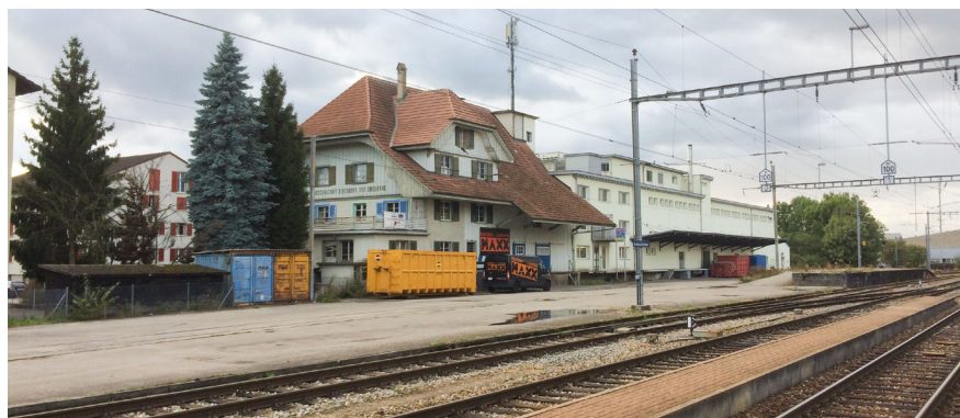
Abb. 8 Areal der ZPP Nr. 14 «Bahnhof Süd» von Osten her gesehen (12. September 2017)
